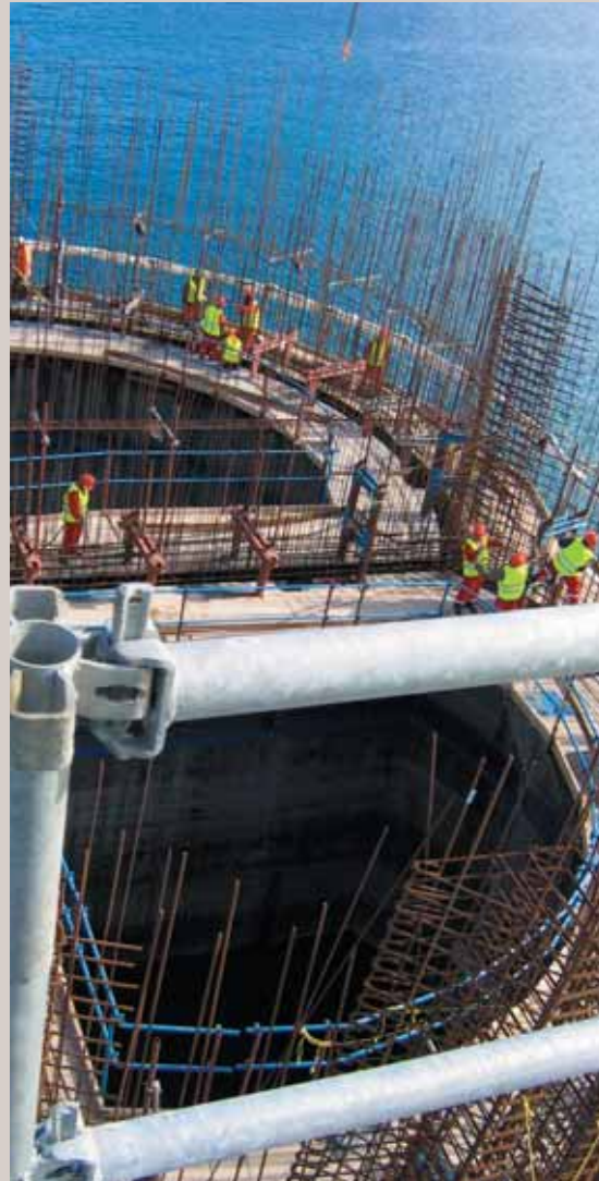
Caisson du port de Tanger-Med
